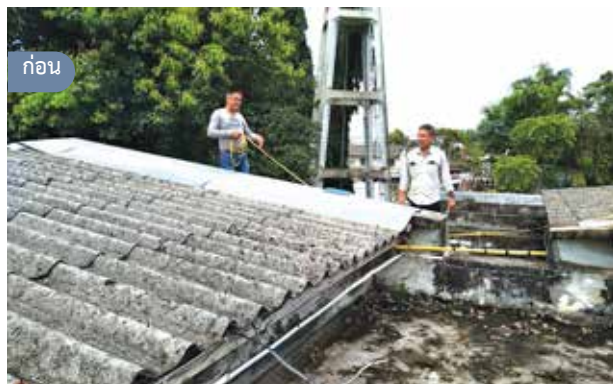
ภาพก่อน - หลัง ซ่อมแซมหลังคา
