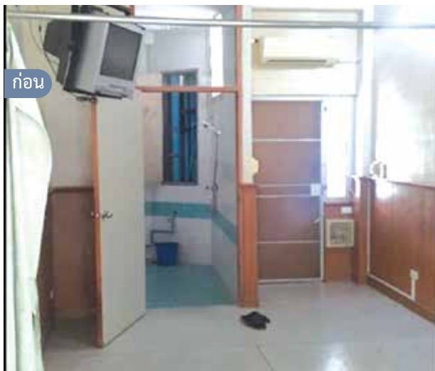
ภาพก่อน - หลังปรับปรุง
